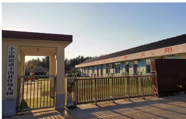
图 2-5 土沟村幼儿园现状
